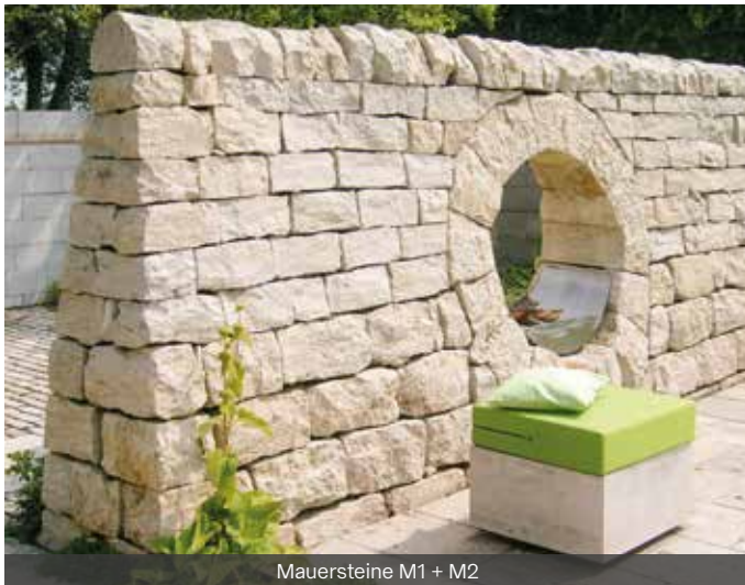
Mauersteine M1 + M2
