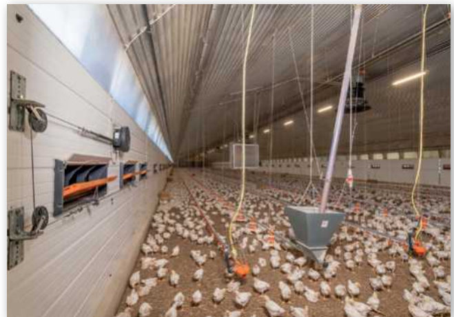
Abbildungen 12 und 13: Deckenzuluft- (links) und Seitenzuluft-Ventile (rechts; Quelle: Big Dutchman International GmbH)
