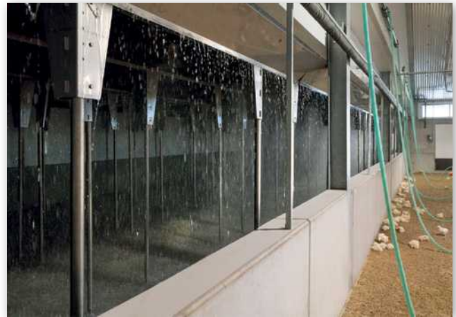
Abbildungen 14 und 15: Abluftwäscher an der Stirnseite des Stalles (links) und in Funktion (rechts; Quelle: Big Dutchman International GmbH)
